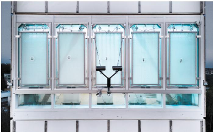
Vue extérieure de la façade d'essai du bâtiment adaptatif de grande hauteur du campus Vaihingen de l'université de Stuttgart, avec les premiers prototypes de façade hydroactive et une technologie de mesure complète.
